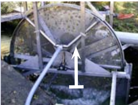
Vue arrière du dégrilleur
